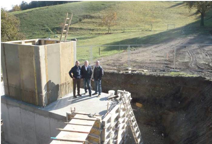
Errichtung Quellstube
