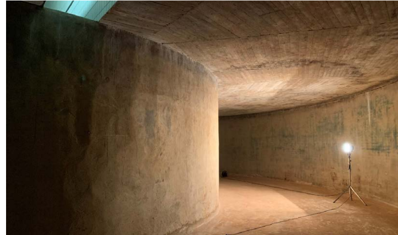
Blick auf die entleerte innere Speicherkammer
