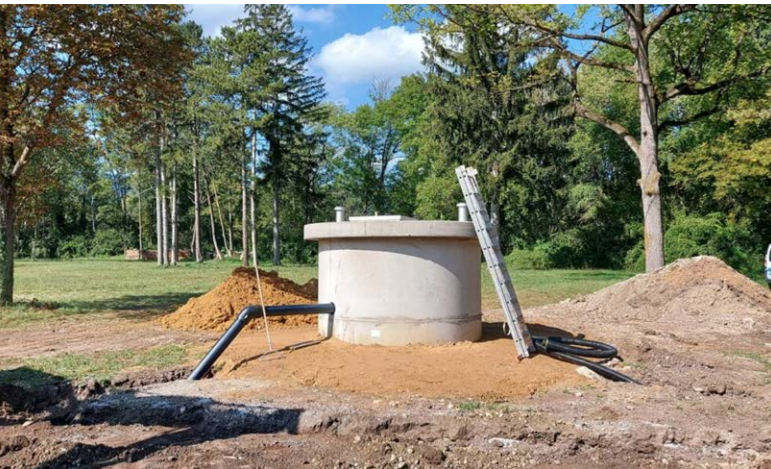
Großvertikalfilterbrunnen/Brunnenschacht
