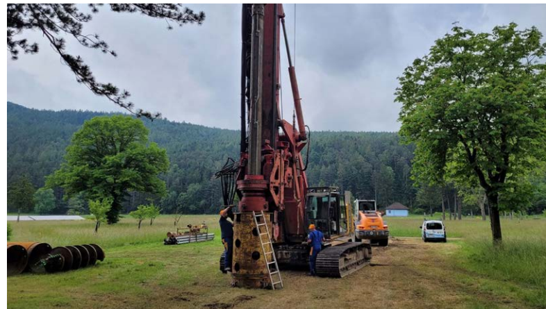
Großvertikalfilterbrunnen Bohrung
