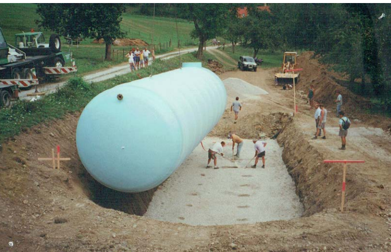
Errichtung Hochbehälter Thann 1998
