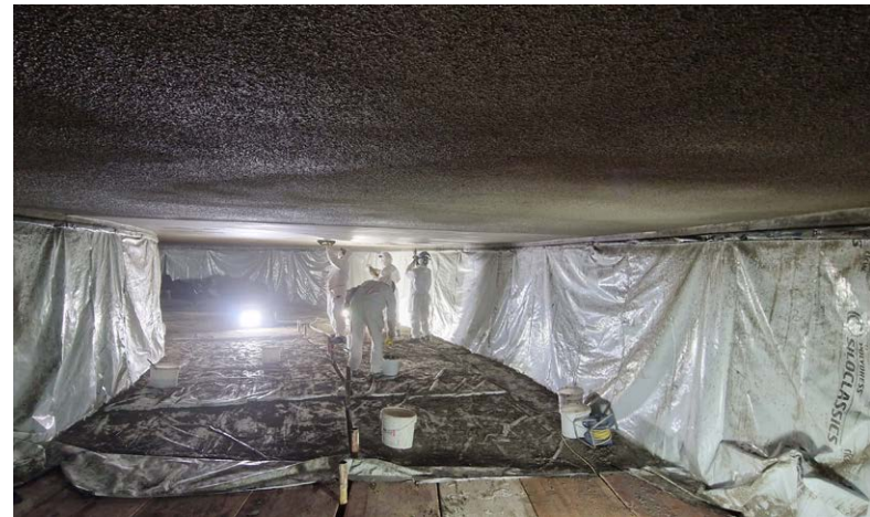
Deckensanierung der Speicherkammern (2023 / 2024)
