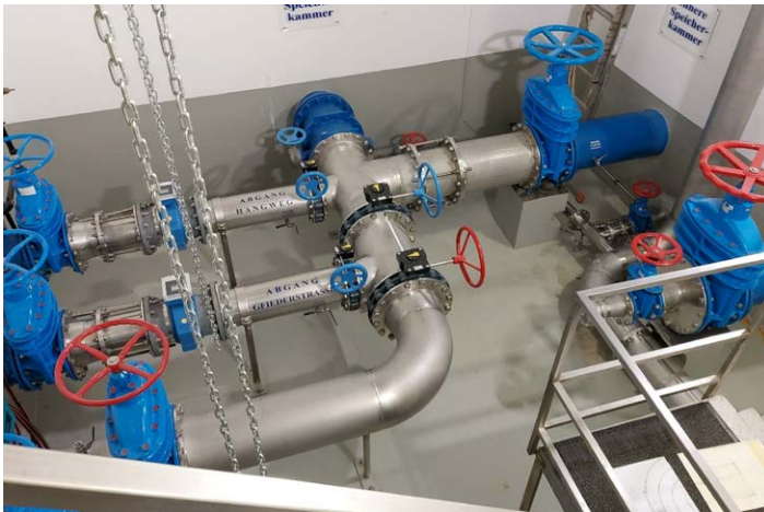
Die im Rohrkeller befindlichen Absperrschieber und Zu- bzw. Abgangsleitungen (DN 250 - 350) wurden 2019 erneuert
