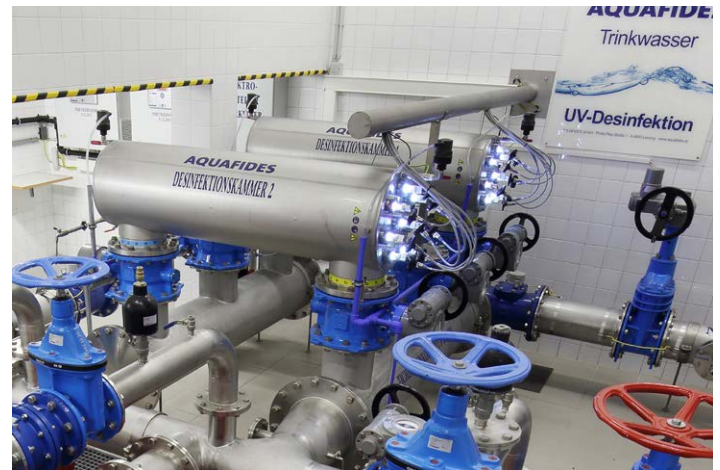
UV-Desinfektionsanlage
