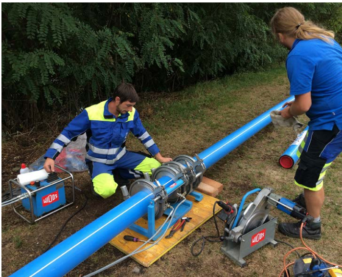
Spiegel- bzw. Stumpfschweißung
